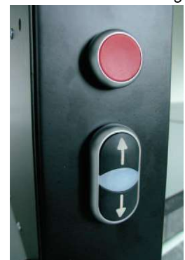
Tastenschalter mit Serviceüberbrückung
