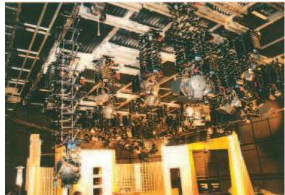
ASS2 System mit Traversen ASS2 system with truss système ASS 2 avec traverses
