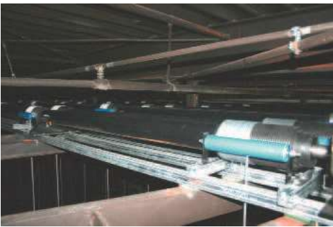
Rohrwellenzüge tube lifts palans à axes creux
