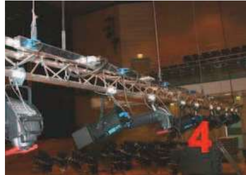
Beleuchtungszug mit junction box lighting bar with junction box porteuse électrique avec boîte de Distribution
