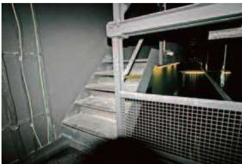
Aufgang Galerie steps gallery montée galerie
