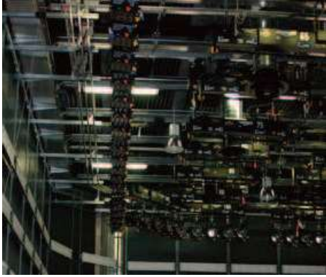
Hoist und Horizontsystem hoist and cyclorama system tractions à moteur et système cyclorama
