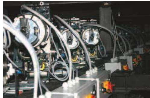
Antriebe Rohrwellenzüge tube lift drives commande palans à axes creux
