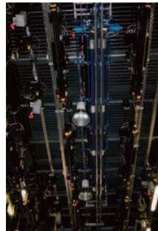
Absenkstation für Horizontsystem lowering station for cyclorama system station d'abaissement pour cyclorama
